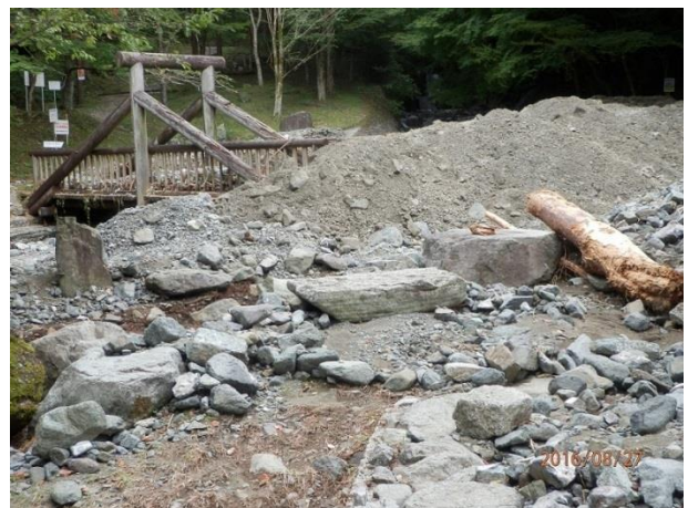
（土石流や流木で埋まった入渓点「葛葉の泉」広場。 橋桁も土石流と流木で埋まっていた）
