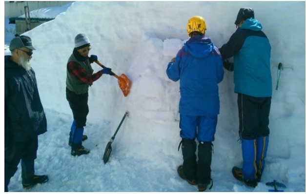
(②入口部分に半お椀型にブロックを積み上げる)
