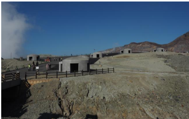
火口見学のそばには新しい避難用シェルターが設置
