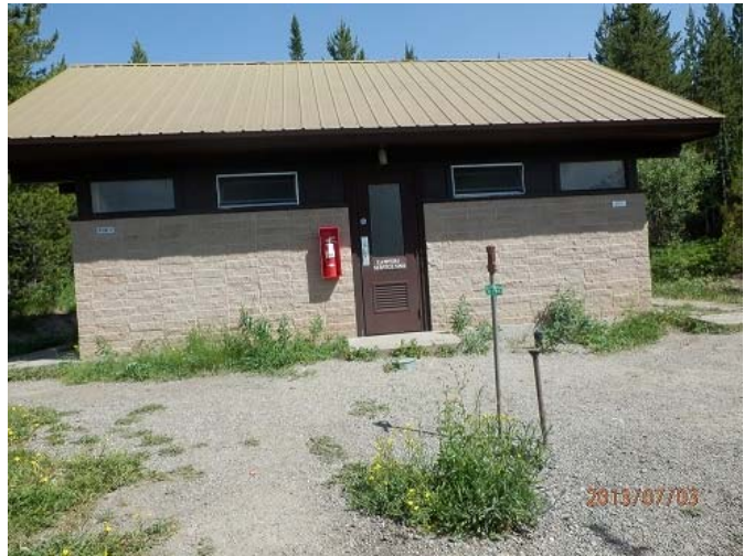
トイレ（細いパイプが飲料水道栓）
